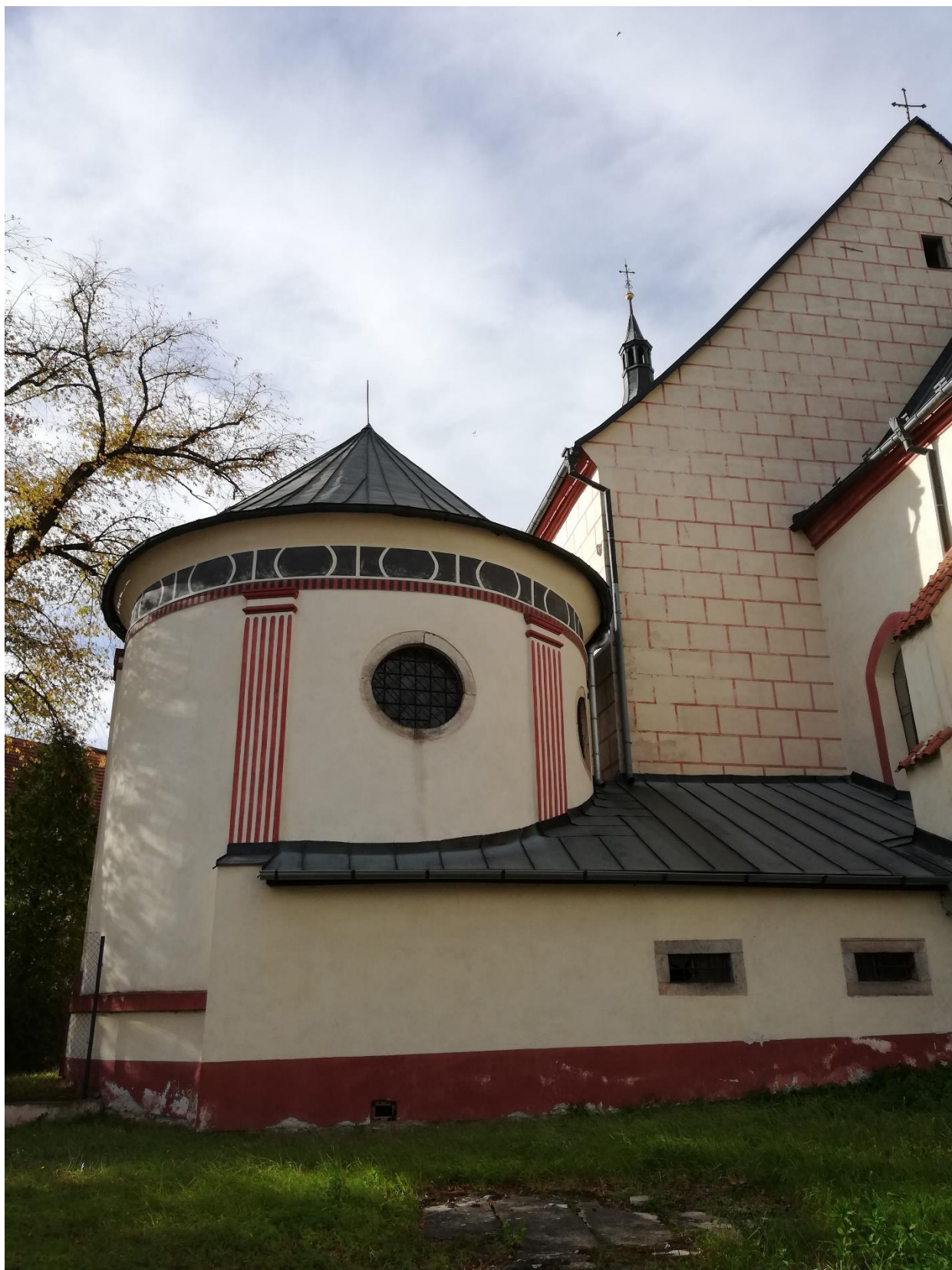
Kaple Porciunkula z roku 1675. S kostelem spojena krátkou chodbou.
